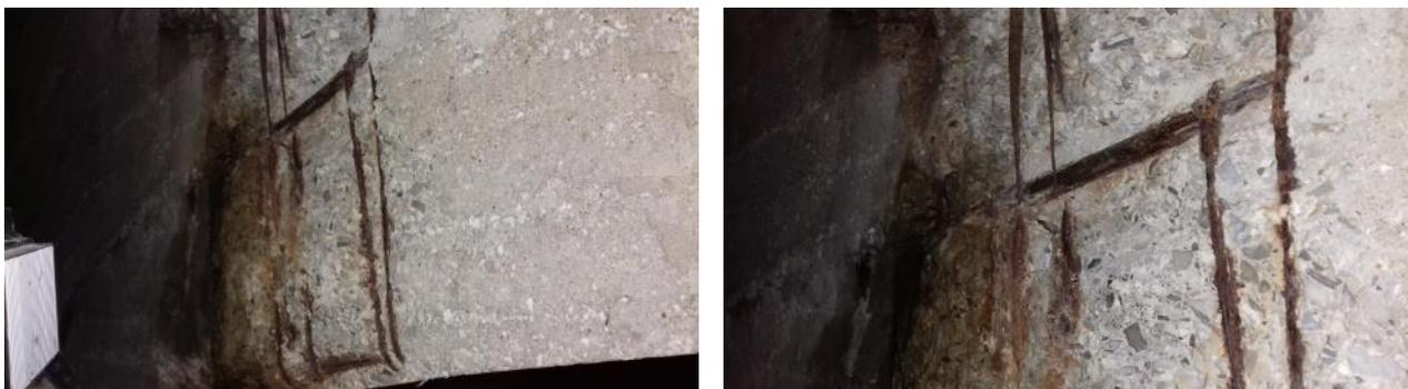
In prossimità di questa zona sono state eseguite prove sclerometriche per stimare la resistenza del cls ed è stato misurato lo spessore di cls carbonatato e di copriferro. Di seguito si riportano i risultati delle indagini:
