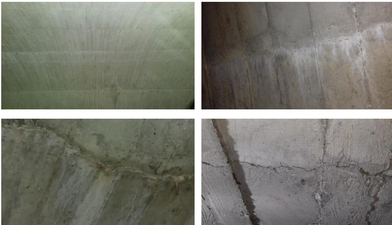
In prossimità della zona al rene lato Firenze dell'arco sono state eseguite prove sclerometriche per stimare la resistenza del cls ed è stato misurato lo spessore di cls carbonatato e di copriferro. Di seguito si riportano i risultati delle indagini:
