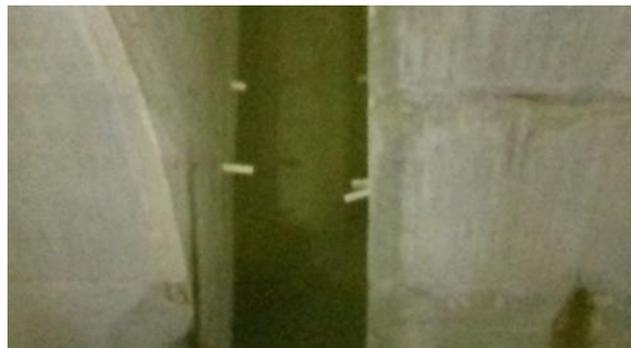
Nella parete di rifianco degli archi 3 e 4 è stata eseguita una foratura a circa 1.30 m dal cordolo in corrispondenza di una precedente percolazione ore asciutta, dalla quale non è fuoriuscita acqua. Nel foro è stato inserito un fibroscopio, ma per l'ampiezza del vano l'illuminazione non è stata sufficiente per esaminare l'interno della struttura.
