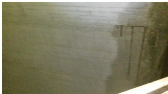
In prossimità della zona al rene dell'arco sono state eseguite prove sclerometriche per stimare la resistenza del cls ed è stato misurato lo spessore di cls carbonatato e di copriferro. Di seguito si riportano i risultati delle indagini:
