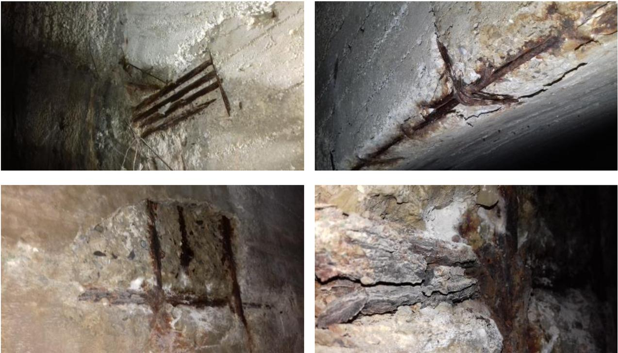
Nella parete laterale e nel rinfiango dell'arco sono state eseguite prove sclerometriche per stimare la resistenza del cls ed è stato misurato lo spessore di cls carbonatato e di copriferro. Di seguito si riportano i risultati delle indagini:
