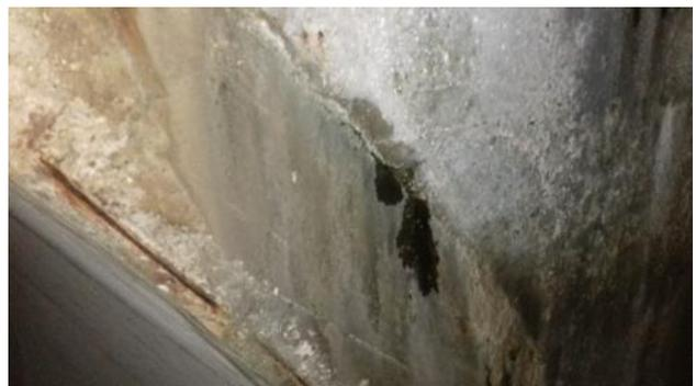
In prossimità della zona di imposta dell'arco su pila 1 il cls di copriferro è localmente in distacco con armatura in vista ossidata e corrosa fino a circa Ø8 mm (in origine Ø12 mm, da elaborati progettuali); sono inoltre presenti alcune lesioni capillari ramificate.
