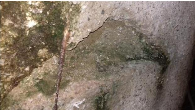
In prossimità di questa zona è stato misurato lo spessore di cls carbonatato e di copriferro. Di seguito si riportano i risultati delle indagini:
